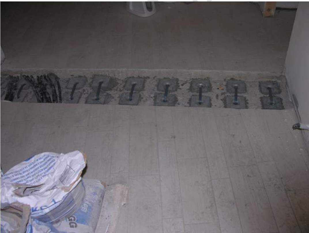
3.3.1.6. Lavorazioni esecutive per intervento con sistema CAM sulle travi
